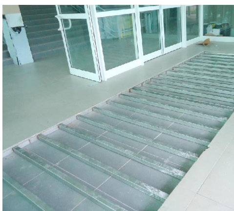
Рис. 15 – Металлическая конструкция под половик второй ступени очистки.
